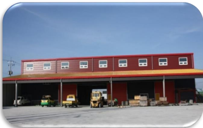
대광산업 공장 신축공사
