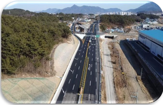
이당일반산업단지 진입도로 개설공사
