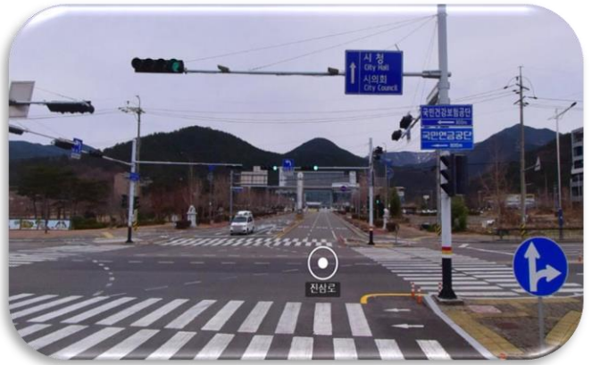
사천시 신청사진입 도로 건설공사
