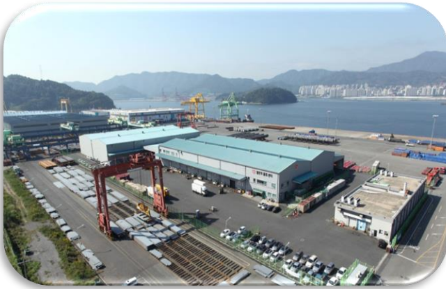
델,디,씨(주) 창원물류창고 신축공사
