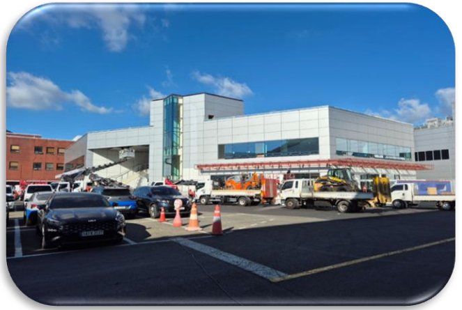
DN솔루션즈 남산공장 복지관 공사
