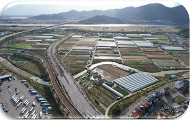
양산물금 택지개발사업지구 교량 3,6호 건설공사
