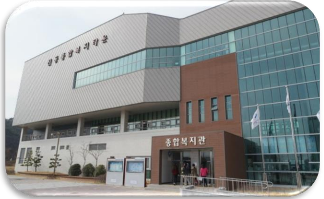
마산 진동종합복지타운 건립공사
