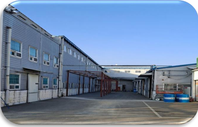
한국스기야마 공장 증축공사
