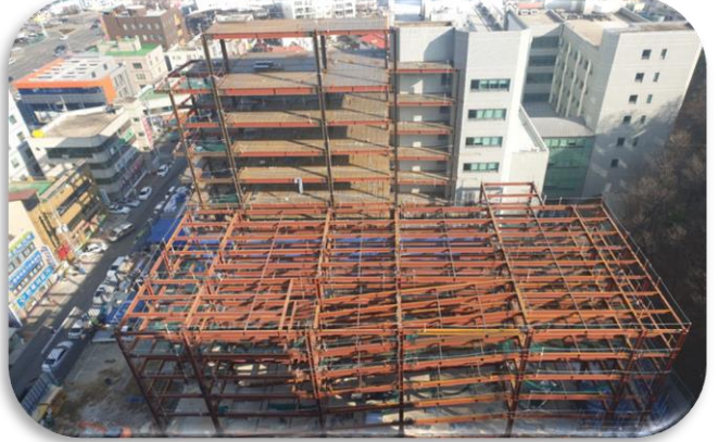
구미 차병원 신축공사 (철골 사진)
