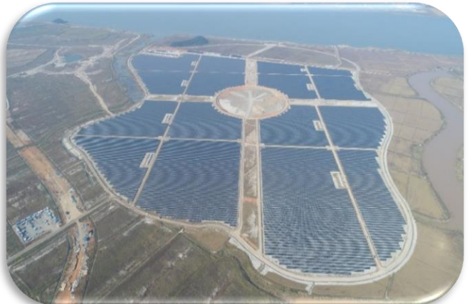
해남 태양광 발전소 (98Mwp)
