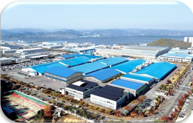
한국경남태양유전(주) 공장 신축공사
