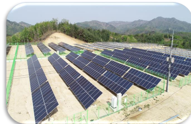
홍천 방내리 태양광 발전소 (5Mwp)
